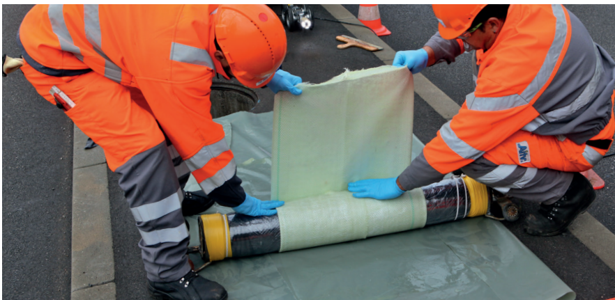
Réparation d'une canalisation avec système de gaine ponctuelle Rep-Liner.
