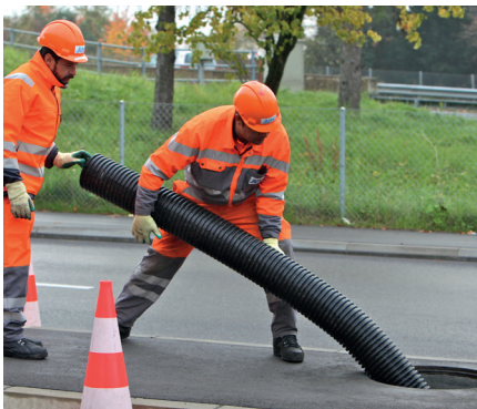
Introduction d'un tubage Flexoren.
